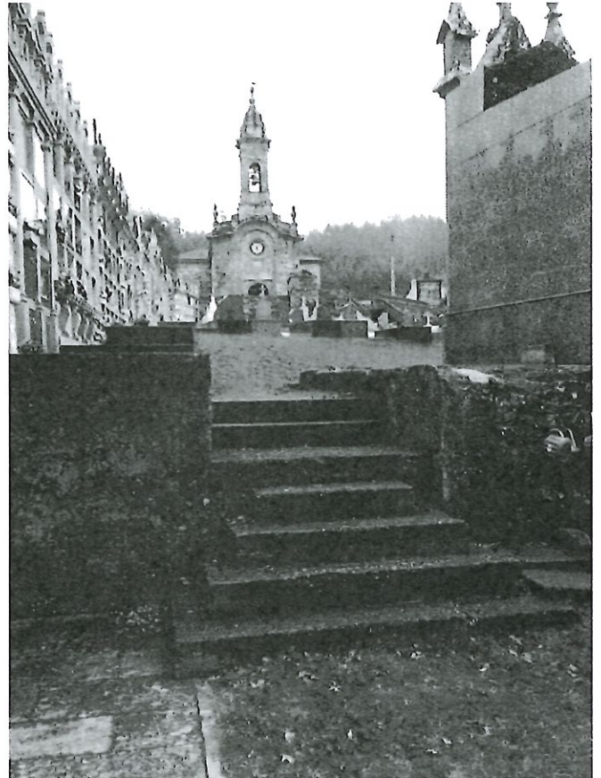
Escafeira que dá acceso á parte ampliada do cemiterio e que se pretende substituír
