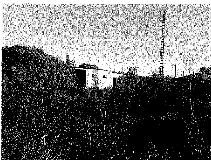
A maleza oculta boa parte da edificación cos vestiarios e o almacén, así como unha das catro torres de iluminación
