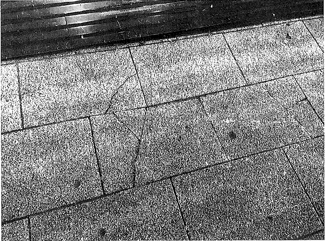
Dous detalles de pavimentos danados na rúa do Doutor Teixeira
