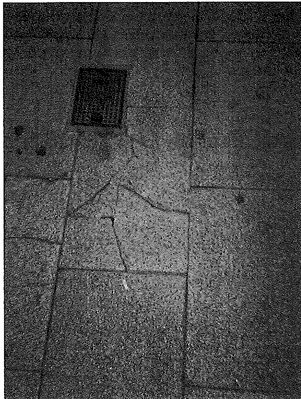
Dous detalles de pavimentos danados na rúa do Doutor Teixeira
